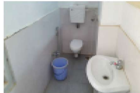
CWSN TOILET PHOTO
